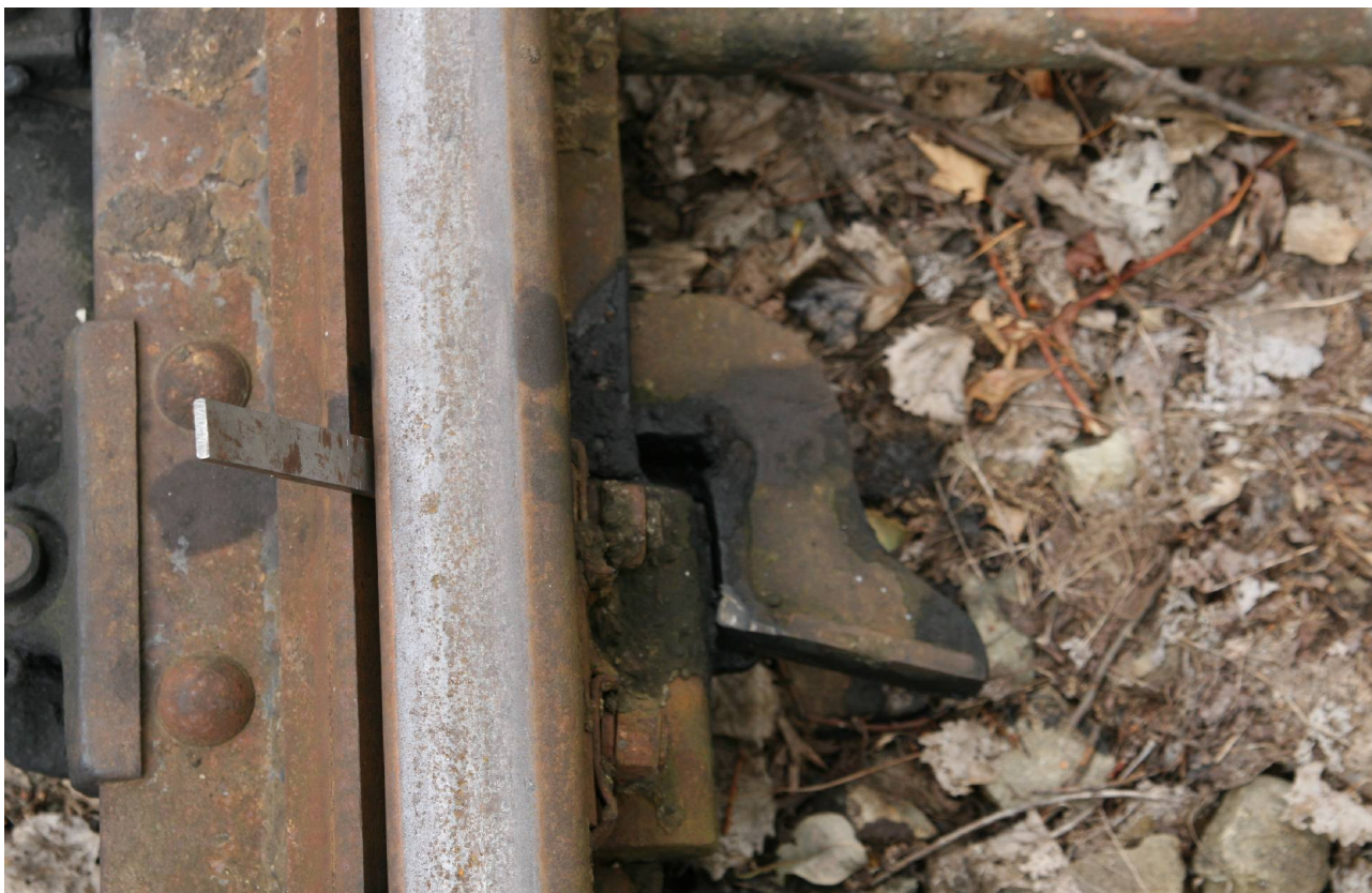
Foto 2: Západková zkouška výhybky č. 45 zkušební měrkou „6 mm“
