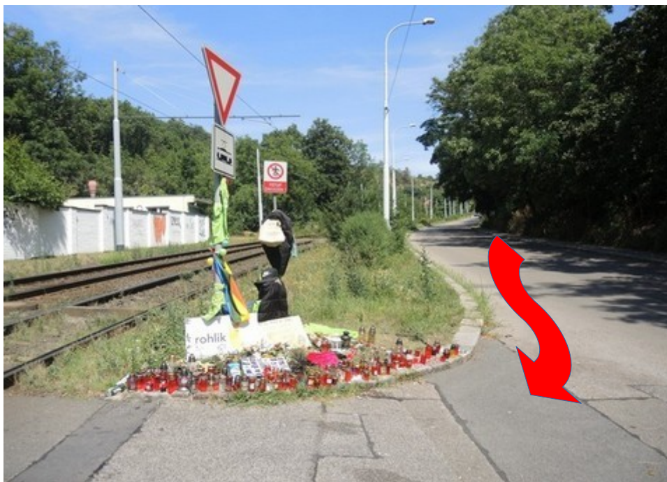
Obr. č. 5: Dopravní značka P 5 natočená nevhodným směrem (nevstřícně řidičům)
