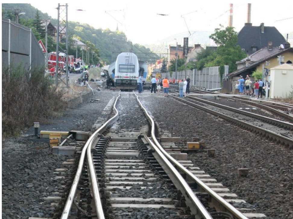
Foto 7: Výhybka č. 105 a zadní část vlaku Os 2316
