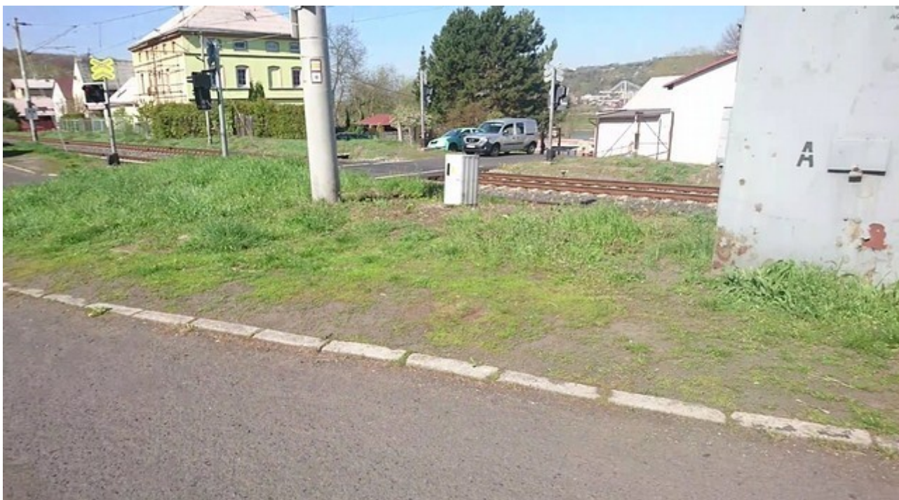
Obrázek č. 7: Viditelnost výstražníku PZS ve výstraze na 25 m (dodatečné měření)
