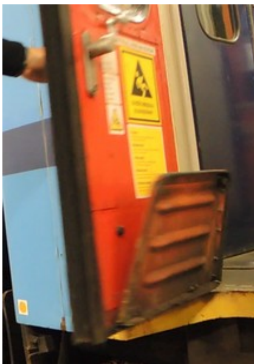
Obr. č. 19: Pohled na vnitřní stranu dveří vozu řady BDs, kde je zámek pro tzv. pětkový klíč zakrytý plechem a nepoužitelný Zdroj: DI
