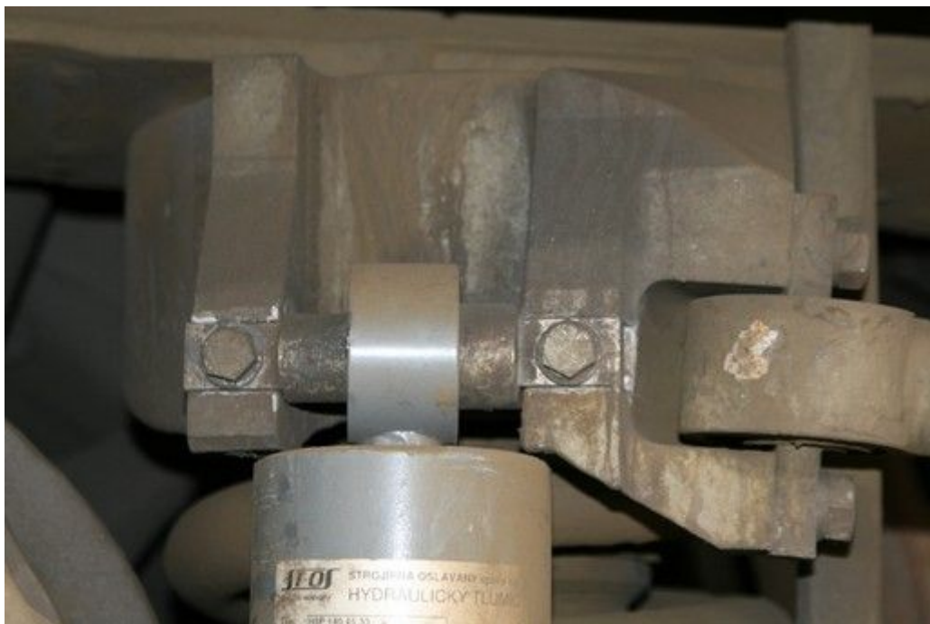
Obr. č. 11: Horní konzole tlumiče v nepoškozeném stavu
