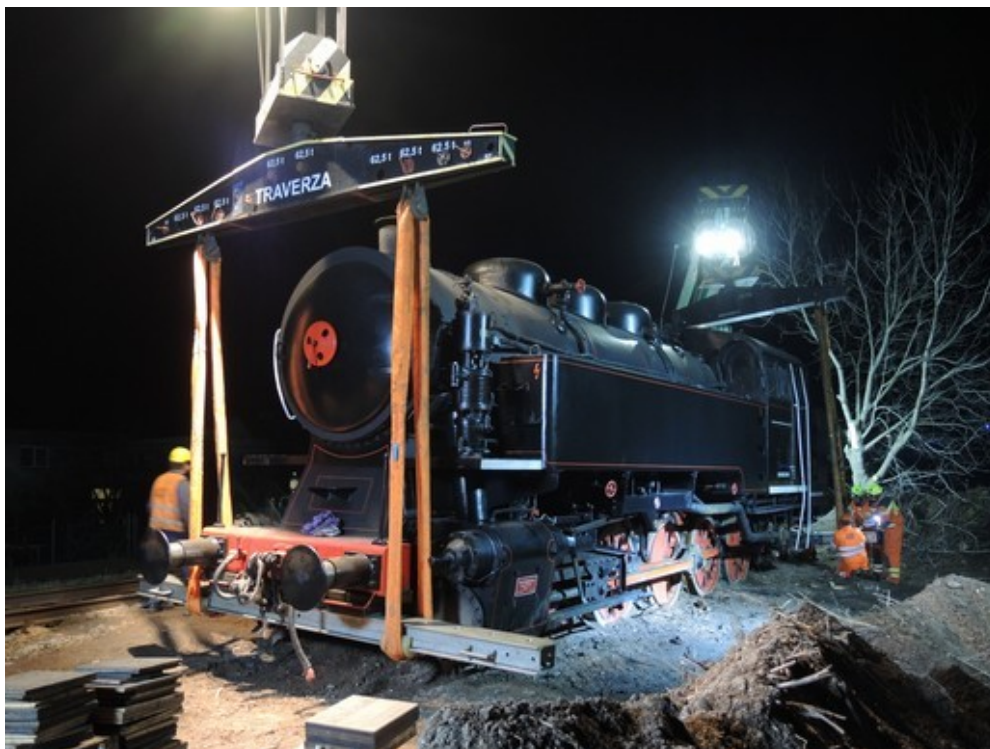
Obr. č. 17: Pohled na práce při tzv. „nakolejování“ parní lokomotivy
