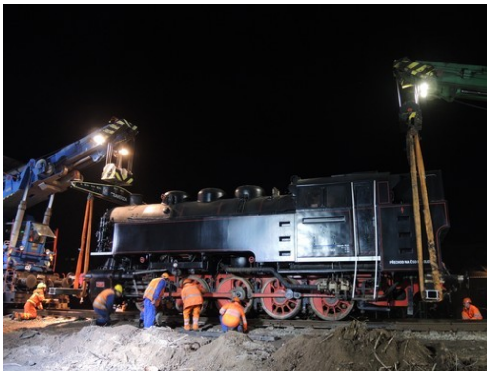
Obr. č. 18: Pohled na práce při tzv. „nakolejování“ parní lokomotivy
