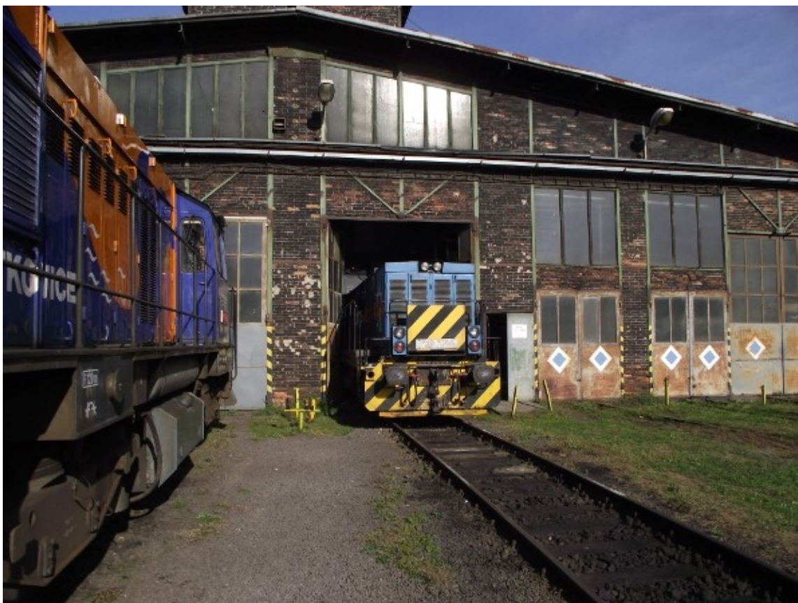
Obr. č. 1: Pohled na HDV 729.617-1 stojící z větší části v hale LD po prolomení vrat haly LD na koleji č. D11.
