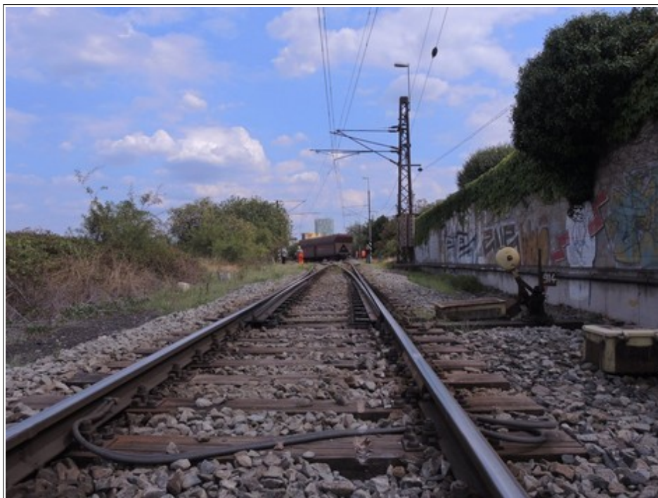
Obr. č. 9: Pohled na výhybku č. 914 v průběhu nehodového děje násilně přestavenou do mezipolohy a v pozadí vykolejené návěstní TDV vlaku Pn 56118.
