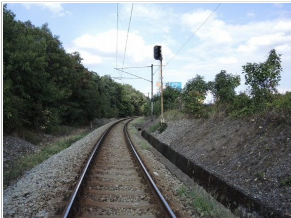
Obr. č. 12: Pohled na návěstidlo OPřKS žst. Praha-Vršovice s. n., za kterým je patrna vpravo TK rostoucí náletová vegetace (keře) negativně ovlivňující viditelnost vjezdového návěstidla KS a jeho návěstí.
