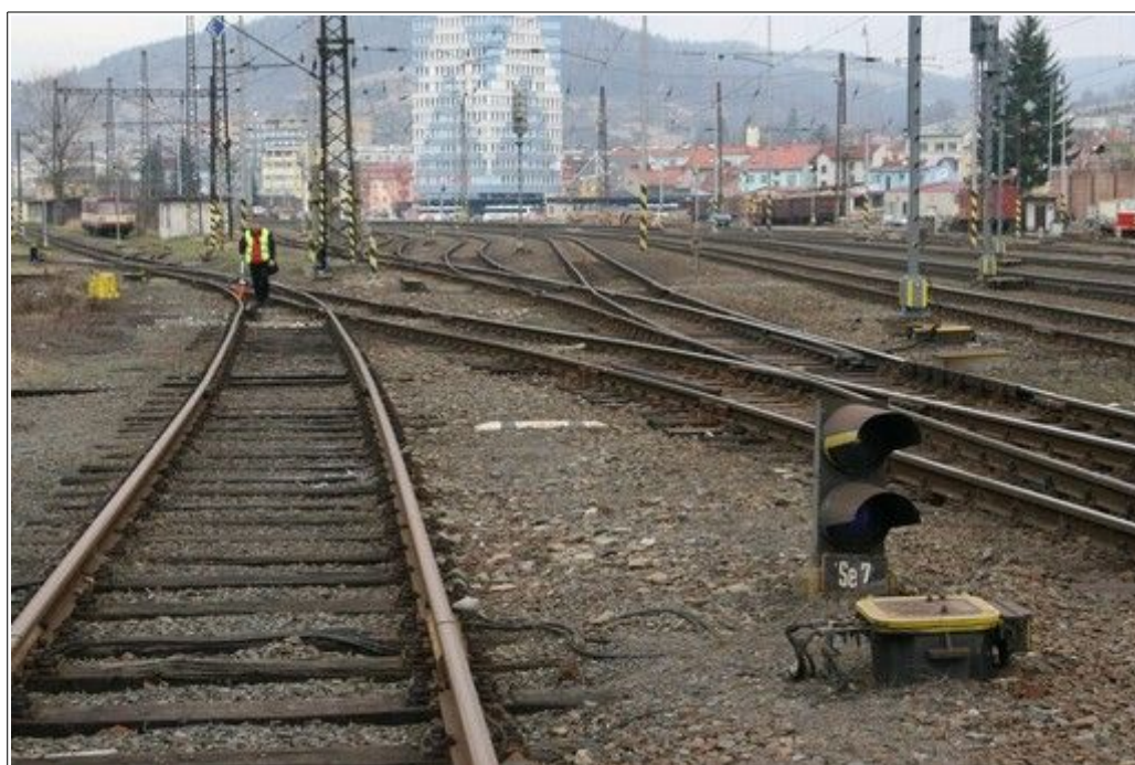
Obr. č. 8: Seřadovací návěstidlo Se7 dráhy celostátní v žst. Vsetín a celkový pohled na kolejiště žst. Vsetín a VK č. 15b a 17b dráhy-vlečky „DKV Olomouc, PP Vsetín“.
