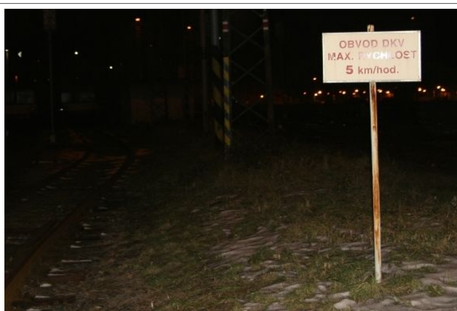
Obr. č. 5: Informativní tabule umístěná v místě styku vzájemně zaústěných drah (na tzv. „Hranici depa“), upozorňující na nejvyšší dovolenou rychlost na dráze-vlečce „Vlečka DKV Olomouc, PP Vsetín“.
