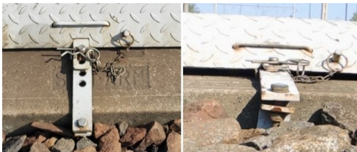
Obr. č. 16: Detailní pohled na zajištění krytu EOV závlačkou
