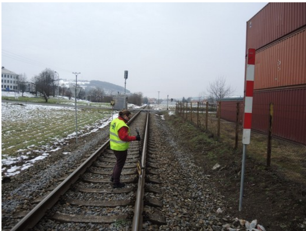
Obr. č. 3: Pohled na výstražné návěstidlo s návěstí „Pískejte“, které bylo umístěno ze směru od železniční stanice Lípa nad Dřevnicí
