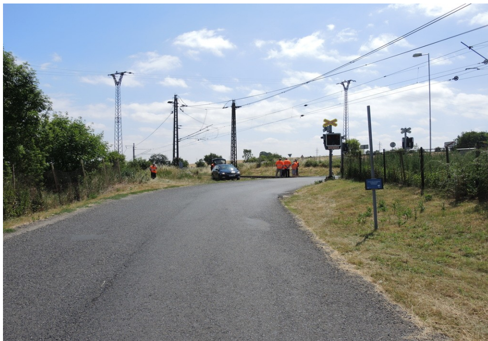
Obr. č. 3: Viditelnost výstražného kříže ze vzdálenosti 40 m
