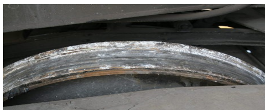
Nákolník DV 88 54 920 0586-8 se stopami jízdy ve vykolejeném stavu
