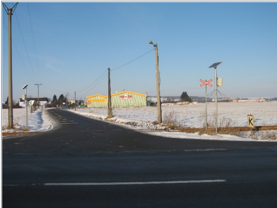
Snímek č. 3: Pohled na ŽP v km 4,981 z křižovatky pozemních komunikací I. třídy č. 57 a III. třídy č. 44346.
