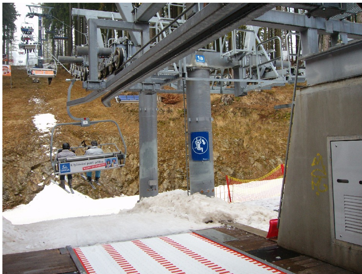
Foto 3: Pohled od ovládacího panelu staničního.
