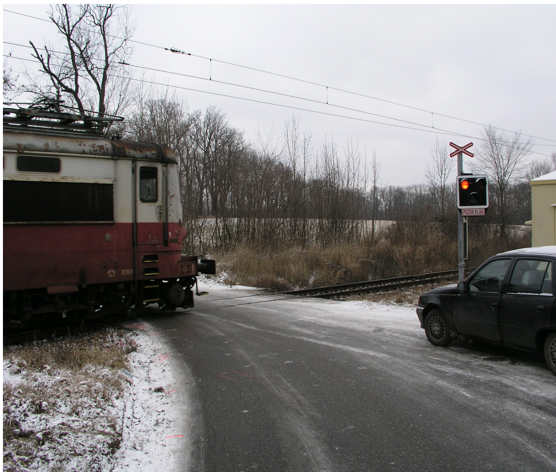
Foto předmětného železničního přejezdu
